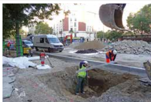
→ Des fosses sont creusées et remplies de terres végétales saines et drainées pour recevoir les arbres du tracé. Les plantations commencent (voir page 4).
