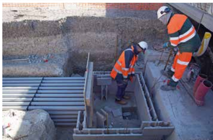
→ Mise en place de la multitubulaire
