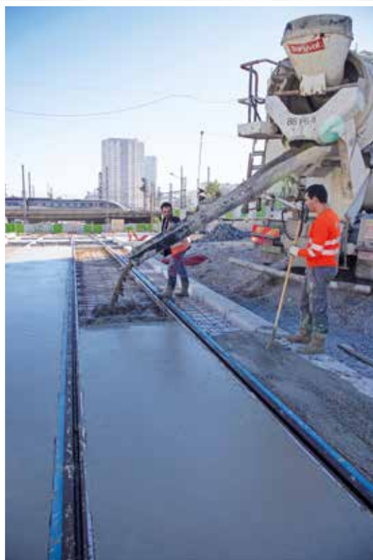
→ Porte de la Chapelle, les travaux de jonction sont achevés. La plateforme poursuit sa progression jusqu'à la porte de Clignancourt, la porte des Poissonniers étant presque achevée.
