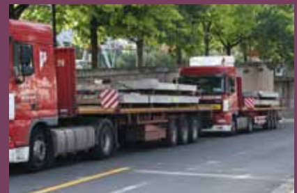
Acheminement des éléments préfabriqués par convoi exceptionnel
